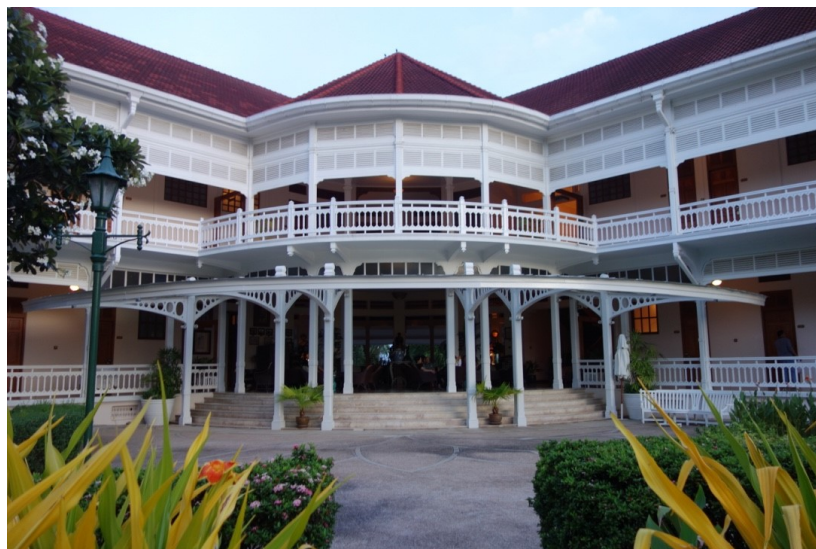
写真10 現在も復元されている鉄道ホテルのベランダ
