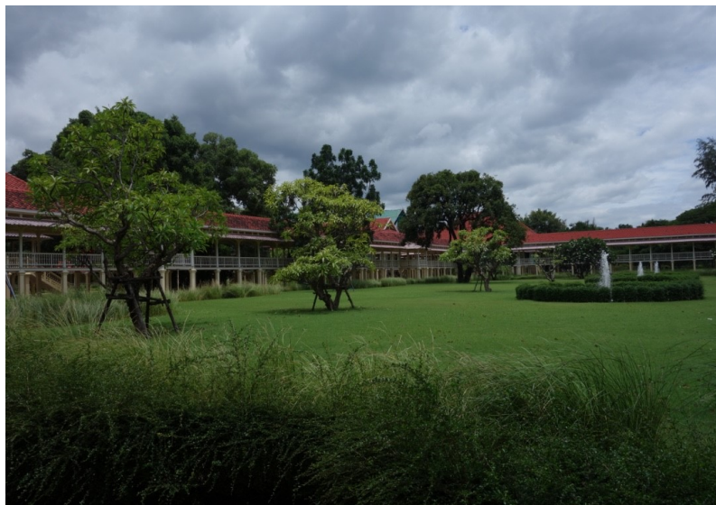
写真13：マルカターイヤワン宮殿 2階立ての長い廊下
